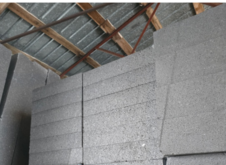
Fot. 4. Prawidłowe składowanie styropianu na placu budowy.
